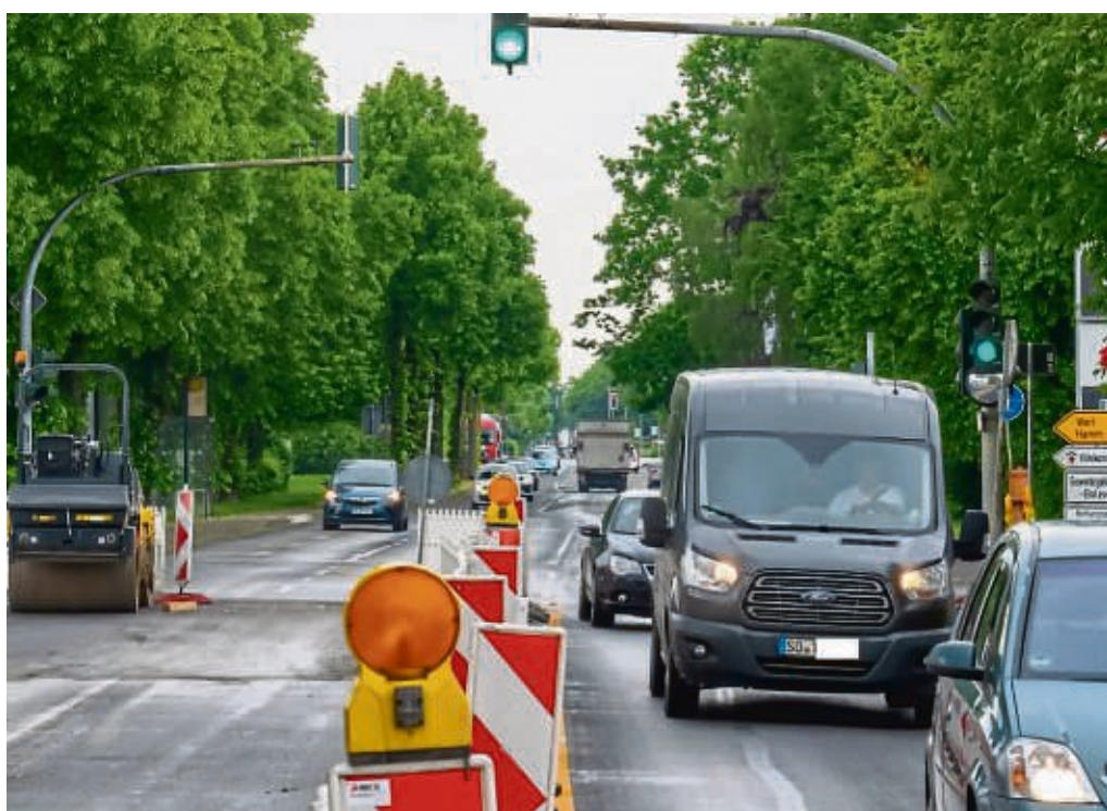
Die Baustelle auf dem Senator-Schwartz-Ring wandert in der kommenden Woche weiter in Richtung Werler Landstraße. FOTO: DAHM
