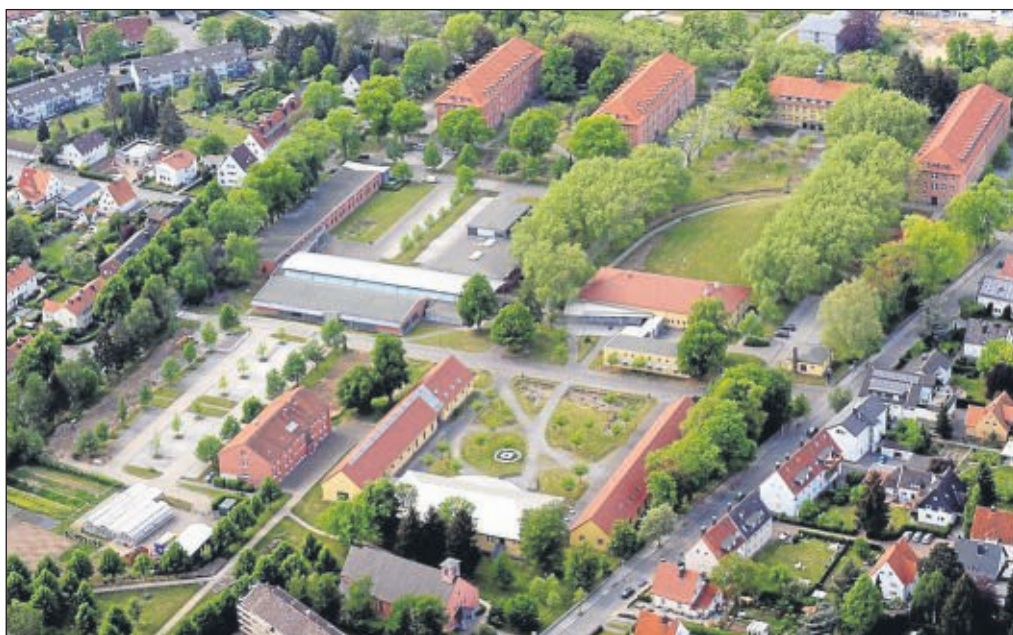
Der Standort Soest der Fachhochschule Südwestfalen aus der Vogelperspektive: Die Blöcke der ehemaligen Kaserne dienen heute dem Lernen. • Foto: Dahm
