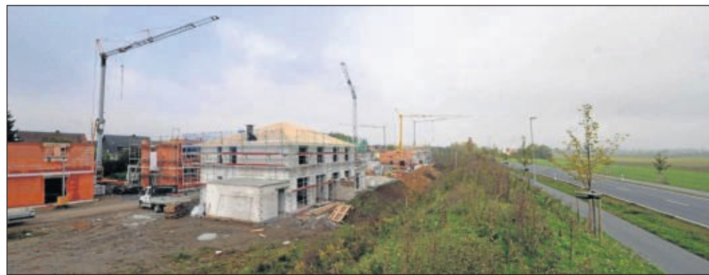
Nur ein Deich trennt das neue Baugebiet am Hogenbergweg (links) vom Danziger Ring. Die 21 Bauplätze hier im Norden Soests gingen weg wie warme Semmeln. ■ Foto: Dahm
